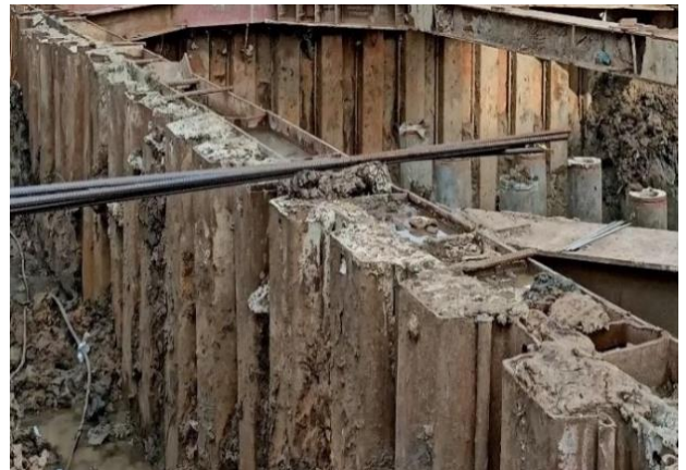
รูปที่ 2.44 แนว Sheet Pile
