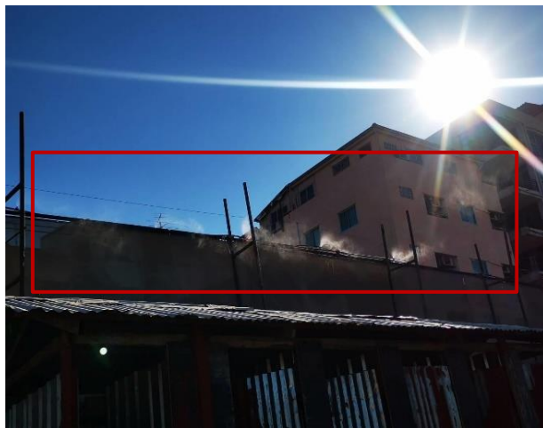
รูปที่ 2.9 Sprinkler บนแนวรั้วโครงการ
